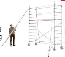
5. Einhängung der oberen Geländerstreben mit Hilfe des HYMER-Lifters vor Einbau der Arbeitsbühne.
